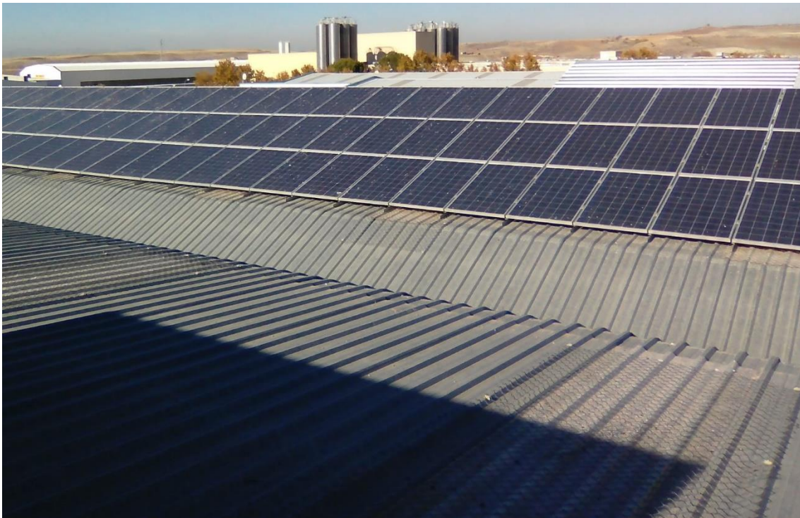
Fig. 2 – Cubierta de la nave industrial
